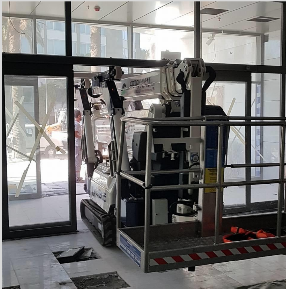
CELA Advanced DT-bæltelifte er smalle nok til at køre gennem en bygnings dør
