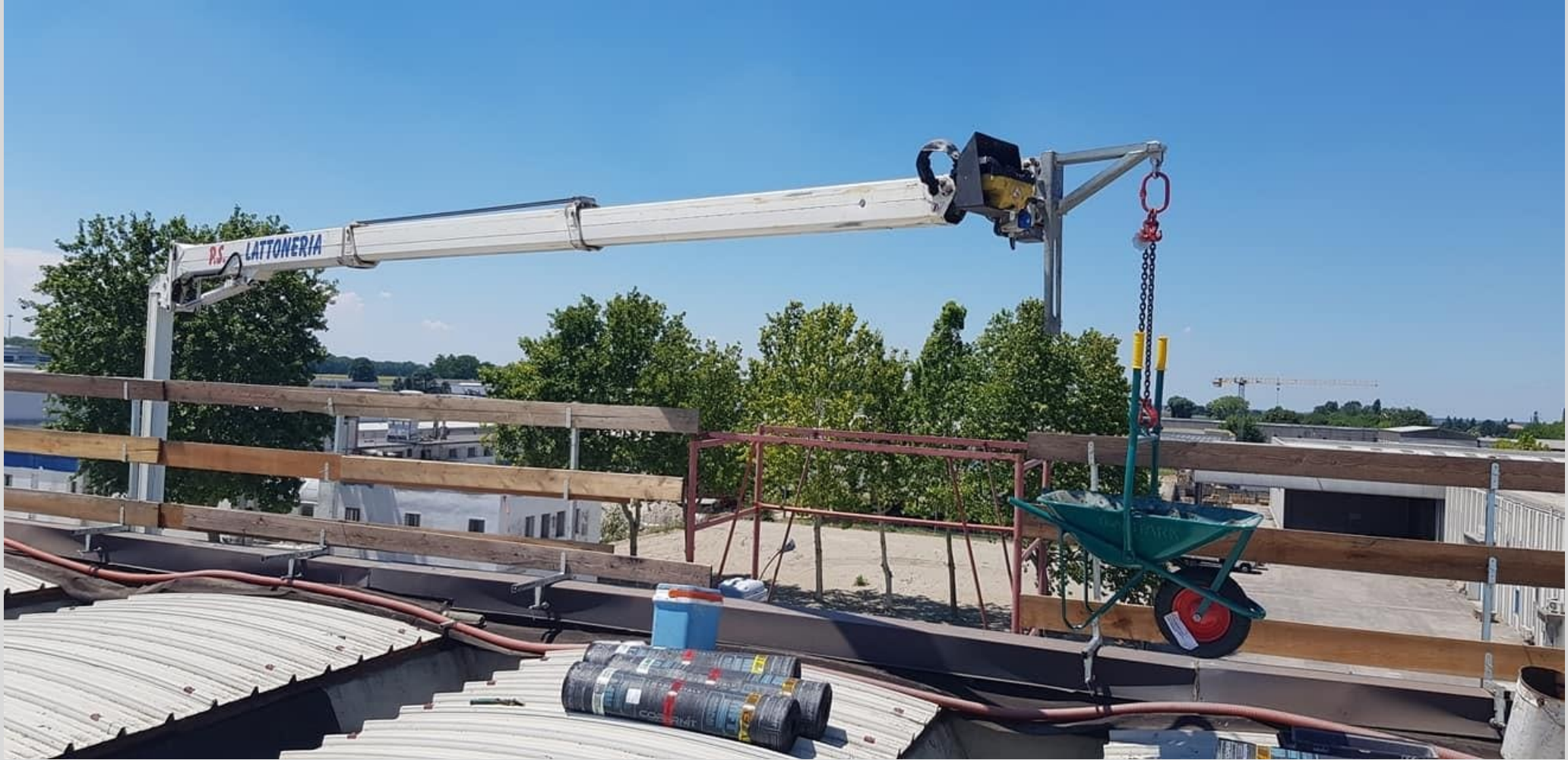
CELA Advanced DT प्लेटफॉर्म एरियल प्लेटफॉर्म और क्रेन, दोनों रूपों में प्रमाणित हैं
