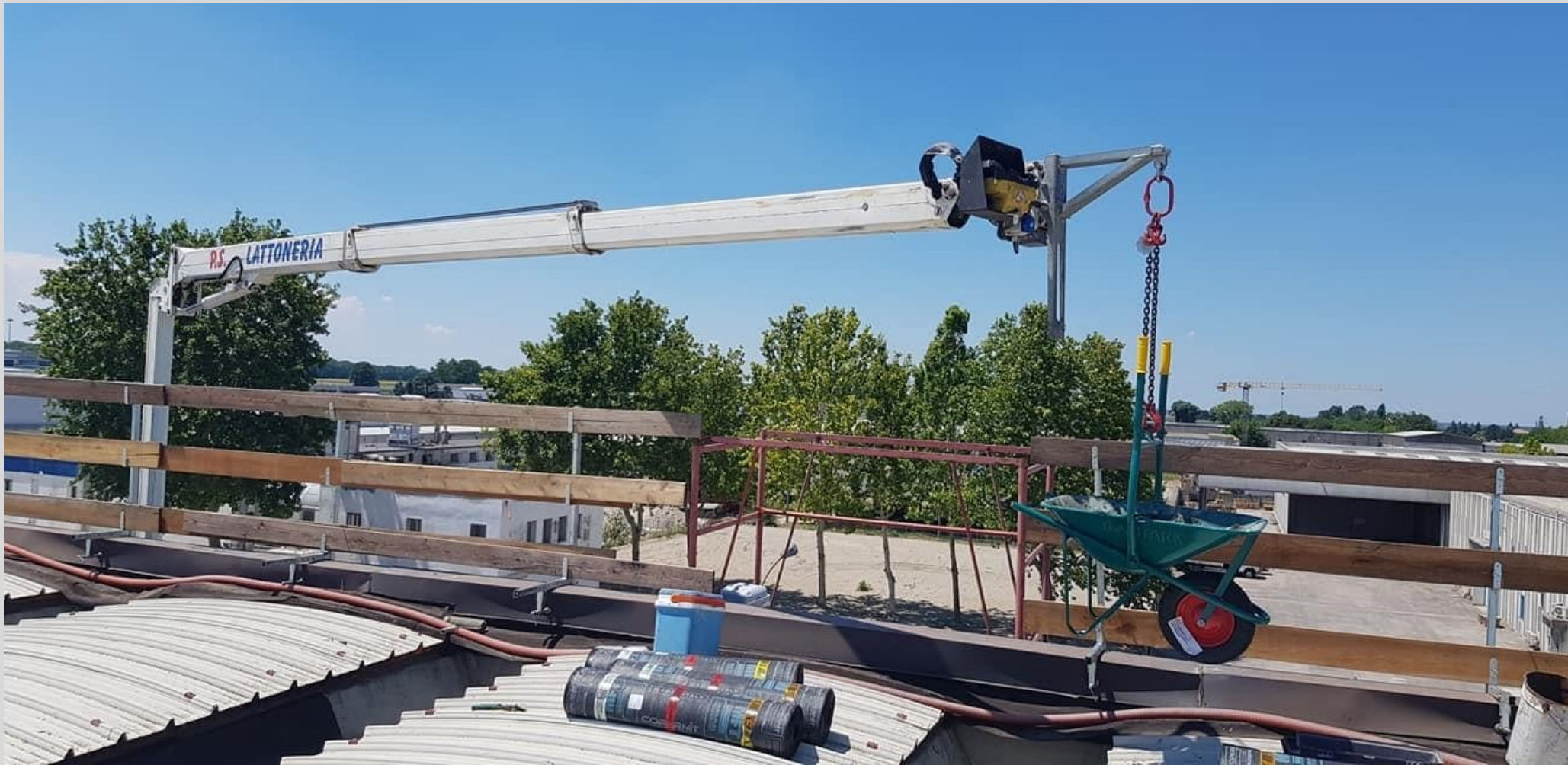
Platform CELA Advanced DT bersertifikat sebagai platform kerja ketinggian sekaligus sebagai crane
